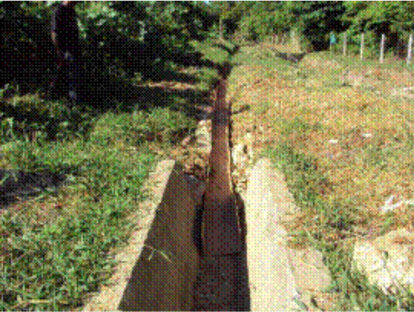
Canalización y conducción de lixiviados en canales de fibra de vidrio
