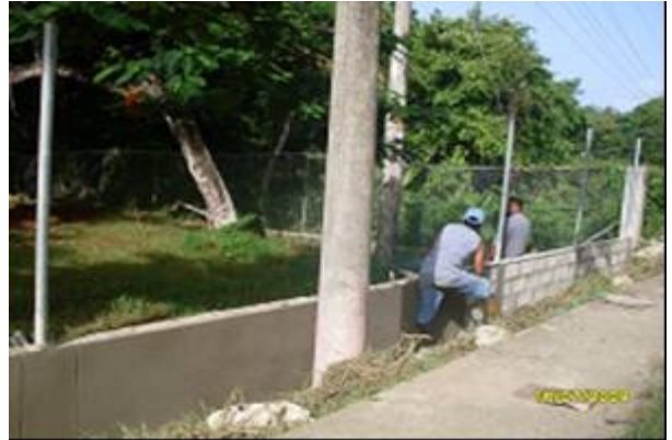
Encerramiento con malla
