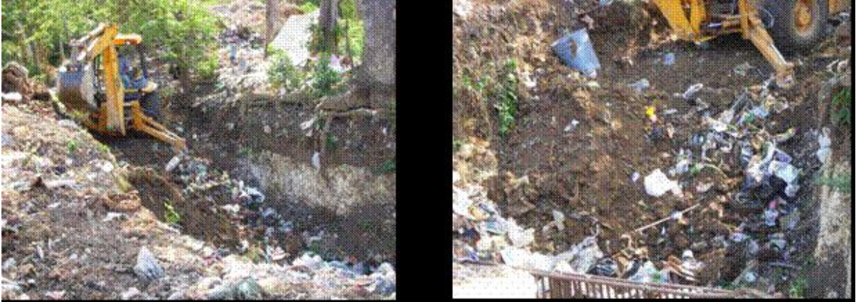
Figuras No. 10 y 11. Trabajos de recuperación de Gullie que atraviesa el Magic Garden.
