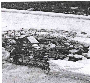
Alcantarillas sin terminar
