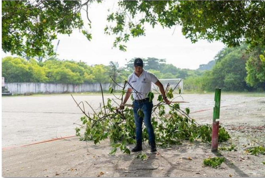
Ilustración No 13. Remoción de material vegetal de la zona en intervención
