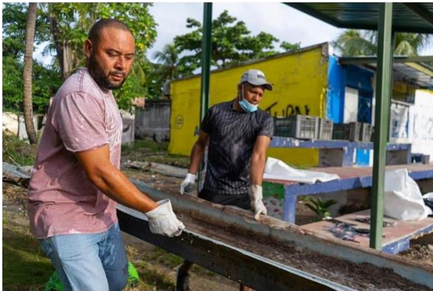
Ilustración No. 14. Remoción de material ferroso de zona en intervención
