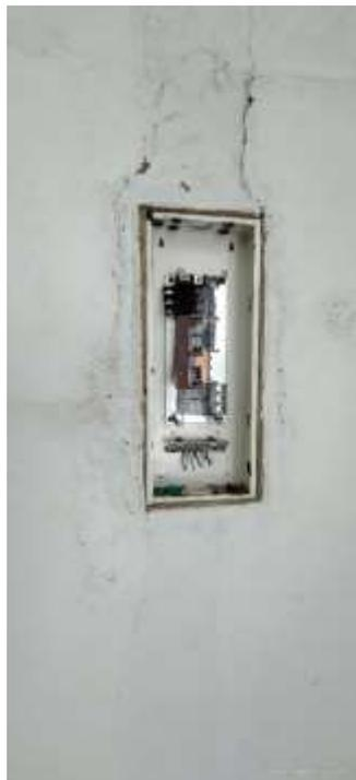
*Ilustración 7 en la ilustración se muestra el estado del Tablero de distribución TAT2, en el cual se evidencia la ausencia de los 13 breaker monopoles de 1x20A y sus accesorios para su correcto funcionamiento. Como también se ve la ausencia de la acometida en cable (3No 8 + 1 No 8 desnudo + 1Ø 1 ¼") el cual contaba con una longitud de 15m. tal como se muestra en las memorias del acta de cobro N°5 del contrato de obra 942 de 2015.*
