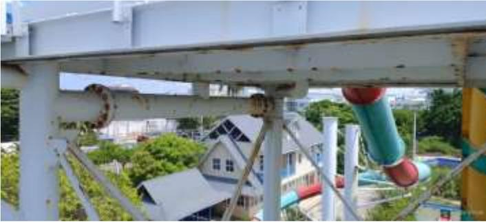
*Ilustración 20 En la ilustración se muestra el estado de los pernos del sistema de soporte de la estructura metálica de la escalera de acceso a los toboganes en su 3er nivel. Se evidencia un grado de oxidación grado A en la cual en el que la cascarilla del elemento en cuestión ha comenzado a desconcharse y se produce una oxidación.*
