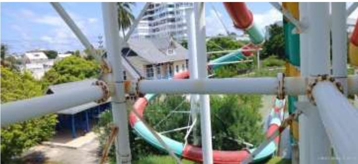
*Ilustración 22 En la ilustración se muestra el estado de los pernos del sistema de soporte de la estructura metálica de la escalera de acceso a los toboganes en su 2do nivel. Se evidencia un grado de oxidación grado A en la cual en el que la cascarilla del elemento en cuestión ha comenzado a desconcharse y se produce una oxidación.*
