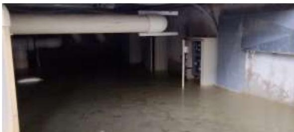
*Ilustración 17 En la ilustracion se muestra el estado del cuarto de bombas de los toboganes, el cual se encuentra totalmente inundado, cubriendo asi 5 bombas de presion, y los traleros electricas de las mismas junto a todos los accesorios requeridos para el control de estas. (se muestra estado de los tableros electricos)*
