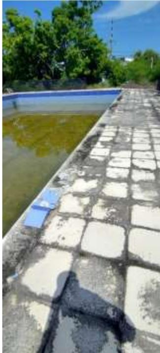
*Ilustración 2 En la ilustración se observa la pérdida de superficie del acabado de piso de la piscina causado por la exposición al sol, la lluvia y falta de limpieza del andén de la piscina.*
