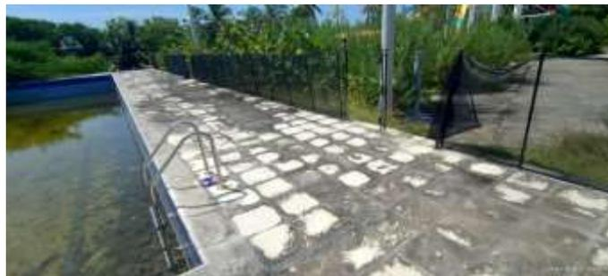
*Ilustración 1 en la ilustración se observa la pérdida de superficie del acabado de piso de la piscina causado por la exposición al sol, la lluvia y la falta de limpieza del andén de la piscina.*
