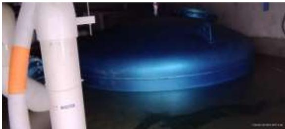
*Ilustración 14 En la ilustracion se muestra el estado del cuarto de bombas de los toboganes, el cual se encuentra totalmente inundado, cubriendo asi 5 bombas de presion, y los traleros electricas de las mismas junto a todos los accesorios requeridos para el control de estas. (Se muestra estado de los filtros de agua.*
