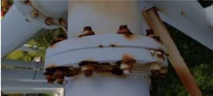
*Ilustración 19 En la ilustración se muestra el estado de los pernos del sistema de soporte de la estructura metálica de la escalera de acceso a los toboganes en su nivel 1. Se evidencia un grado de oxidación grado A en la cual en el que la cascarilla del elemento en cuestión ha comenzado a desconcharse y se produce una oxidación.*
