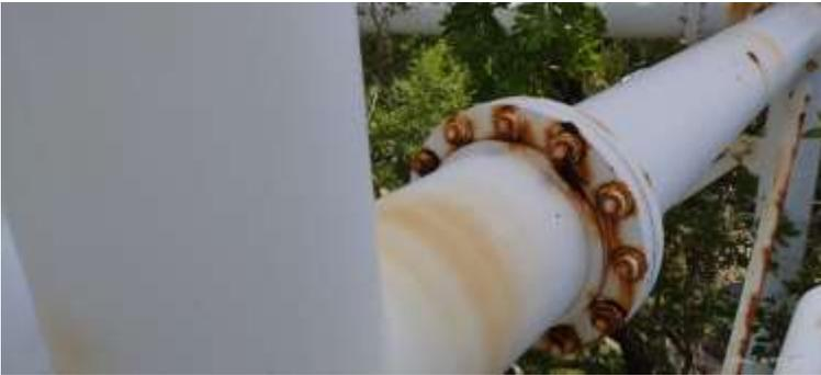
*Ilustración 21 En la ilustración se muestra el estado de los pernos del sistema de soporte de la estructura metálica de la escalera de acceso a los toboganes en su 2do nivel. Se evidencia un grado de oxidación grado A en la cual en el que la cascarilla del elemento en cuestión ha comenzado a desconcharse y se produce una oxidación.*
