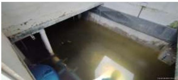
*Ilustración 15 En la ilustracion se muestra el estado del cuarto de bombas de los toboganes, el cual se encuentra totalmente inundado, cubriendo asi 5 bombas de presion, y los traleros electricas de las mismas junto a todos los accesorios requeridos para el control de estas.*
