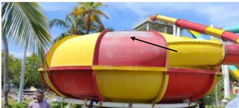
*Ilustración 23 En la ilustracion se muestra el estado del deslizadero Hidroflush, el cual presenta una exposicion de superficial de la fibra de vidrio por la exposicion a los agentes climaticos como el sol y el agua.*
