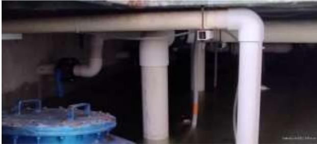
*Ilustración 18 En la ilustración se muestra el estado del cuarto de bombas de los toboganes, el cual se encuentra totalmente inundado, cubriendo así 5 bombas de presión, y los tableros eléctricos de las mismas junto a todos los accesorios requeridos para el control de estas. (se muestra estado de los filtros de agua)*
