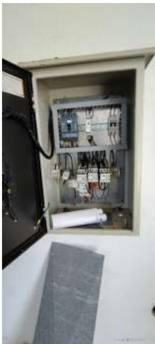
*Ilustración 9 En la ilustración se muestra el estado del tablero secundario del cuarto de bomba, el cual se observa la ausencia de todos los cables cobrizados y sus breakers.*
