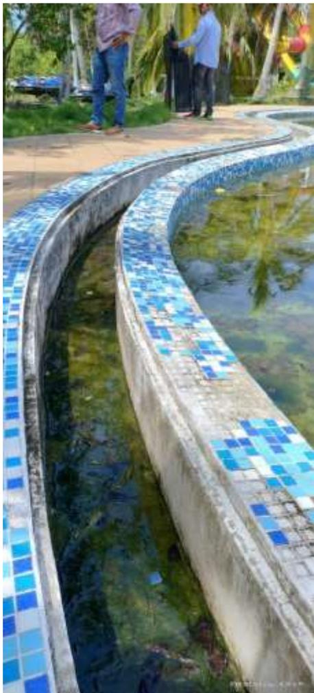
*Ilustración 33 En la ilustración se muestra el estado de enchapado de piso y la ausencia de las rejillas de piso.*
