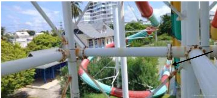
Ilustración 26 En la ilustración se muestra al fondo el estado del deslizadero Endoespina, el cual presenta una exposición superficial de la fibra de vidrio por la exposición a los agentes climáticos como el sol y el agua.
