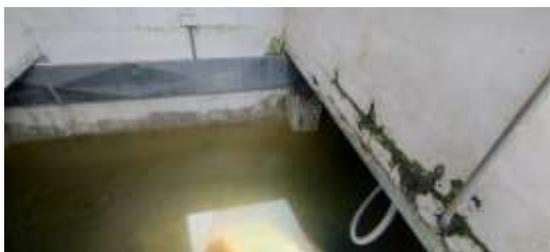
*Ilustración 13 En la ilustración se muestra el estado del cuarto de bombas de los toboganes, el cual se encuentra totalmente inundado, cubriendo así 5 bombas de presión, y los tableros eléctricos de las mismas junto a todos los accesorios requeridos para el control de estas. (se muestra estado del acceso al cuarto de bombas).*
