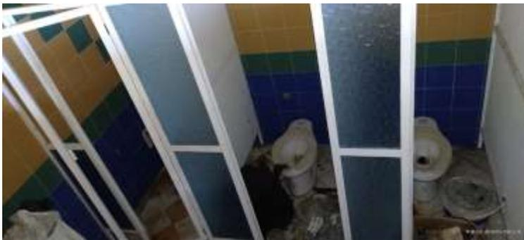
*Ilustración 29 En la ilustración se muestra el estado los aparatos sanitarios de los baños públicos del parque, los cuales se evidencia la ausencia de los fluxómetros necesarios para el funcionamiento de los mismos.*
