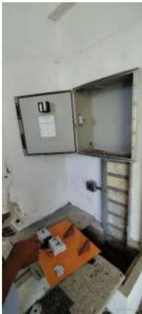
*Ilustración 10 En la ilustración se muestra el estado del tablero de distribución del cuarto eléctrico al cuarto de bombas, el cual se observa el desmonte de todos los accesorios eléctricos y la ausencia de todos los cables cobrizados de esta y de sus bancos de distribución.*
