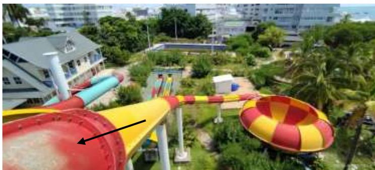
*Ilustración 25 En la ilustracion se muestra el estado del deslizadero Hidroflush, el cual presenta una exposicion de superficial de la fibra de vidrio por la exposicion a los agentes climaticos como el sol y el agua.*
