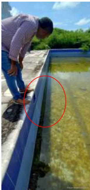
*Ilustración 3 En la ilustración se observa el levantamiento de las baldosas correspondiente al recubrimiento del vaso de la piscina.*
