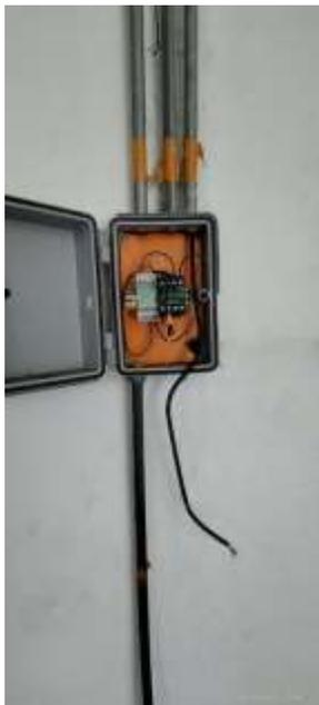
*Ilustración 8 En la ilustración se muestra el estado del tablero de alumbrado interior del cuarto de bomba, el cual se observa la ausencia de todos los cables cobrizados.*
