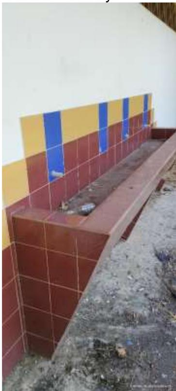
Ilustración 27 En la ilustración se muestra el estado de las griferías de los baños públicos del parque, los cuales se evidencia la ausencia de estos in situ.
