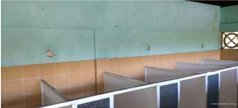
*Ilustración 28 En la ilustración se muestra el estado los plafones de iluminación de los baños públicos del parque, los cuales se evidencia la ausencia de estos in situ.*
